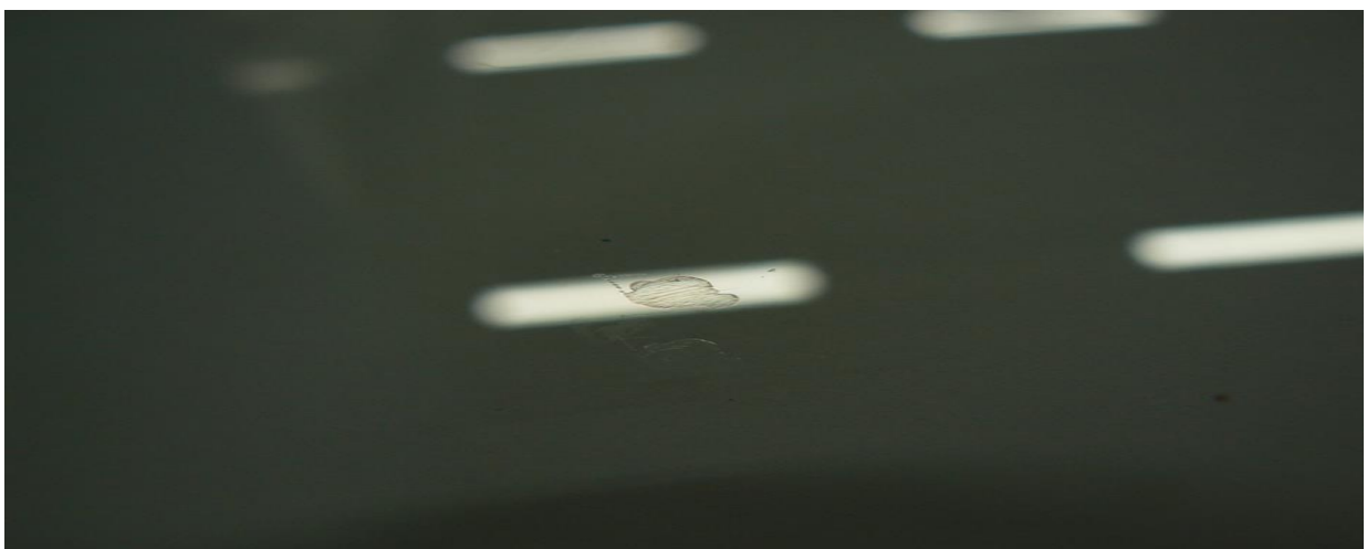
GOED: Sterreparatie voldoende gevuld en oppervlakte afgewerkt
