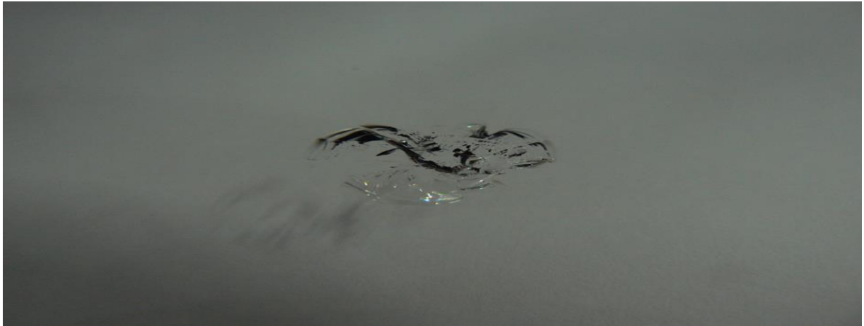
FOUT: Breuk onvoldoende gevuld en onvoldoende hechting.
