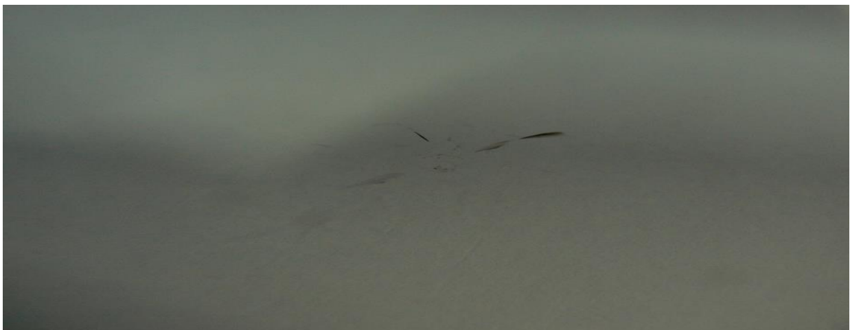
FOUT: Combinatiebreuk wel voldoende gevuld maar oppervlakte niet afgewerkt.
