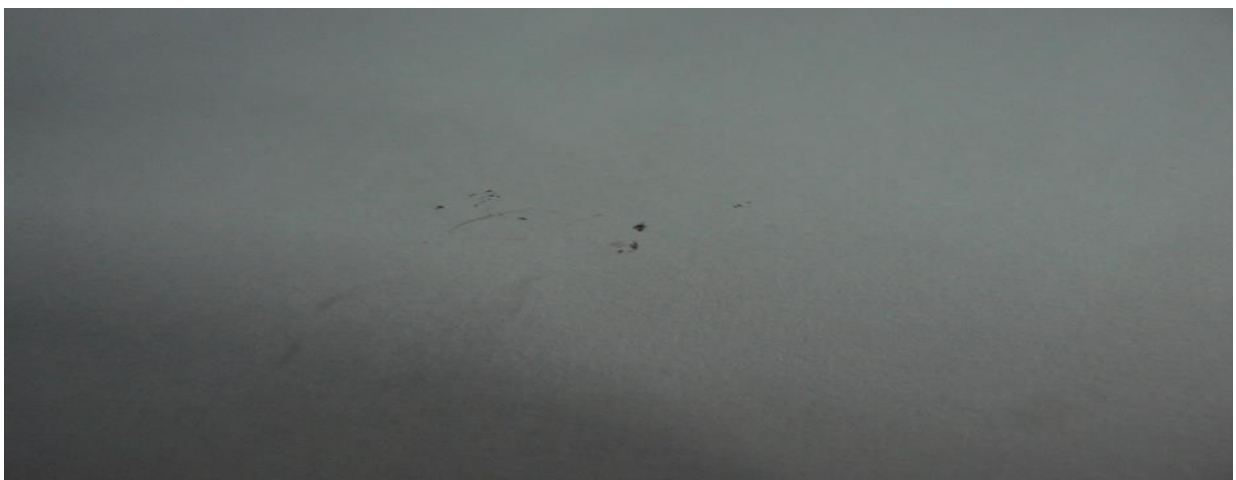
GOED: Breuk voldoende gevuld, voldoende hechting en oppervlakte afgewerkt.
